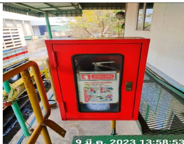
ถังดับเพลิงชนิดก๊าซคาร์บอนไดออกไซด์ บริเวณสำนักงาน บริษัท บ้านปู จำกัด (มหาชน)
