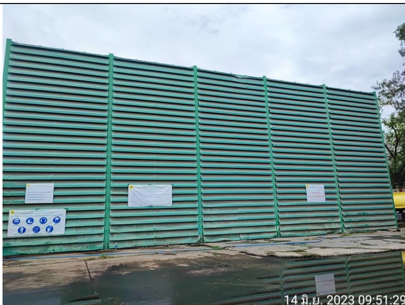
รูปที่ 2.2-17 กำแพงกันลมบริเวณหน้าท่าเทียบเรือ
