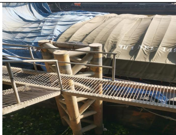
เสากันกันกระแทก (ตรวจสอบการชำรุดสึกหรอ/ผุกร่อน/แตกร้าว)
