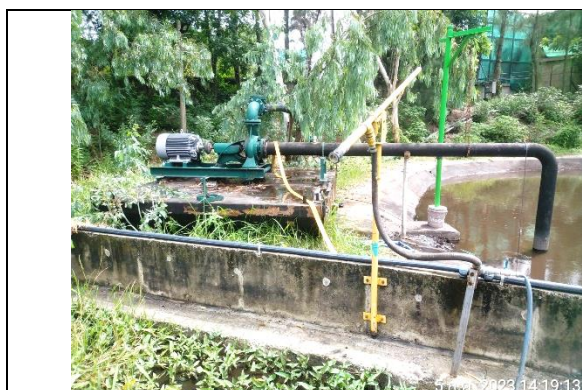
รูปที่ 2.2-45 เครื่องสูบน้ำในบ่อตกตะกอน 2
