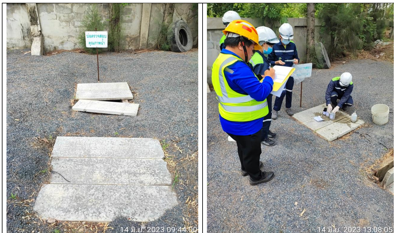
รูปที่ 2.2-32 บ่อตรวจสอบคุณภาพน้ำ (บ่อพักน้ำก่อนระบายน้ำออกนอกโครงการ)
