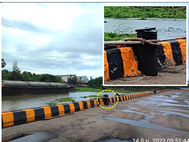
หลักผูกเรือ (ตรวจสอบการชำรุดสึกหรอ/ผุกร่อน/แตกร้าว)
