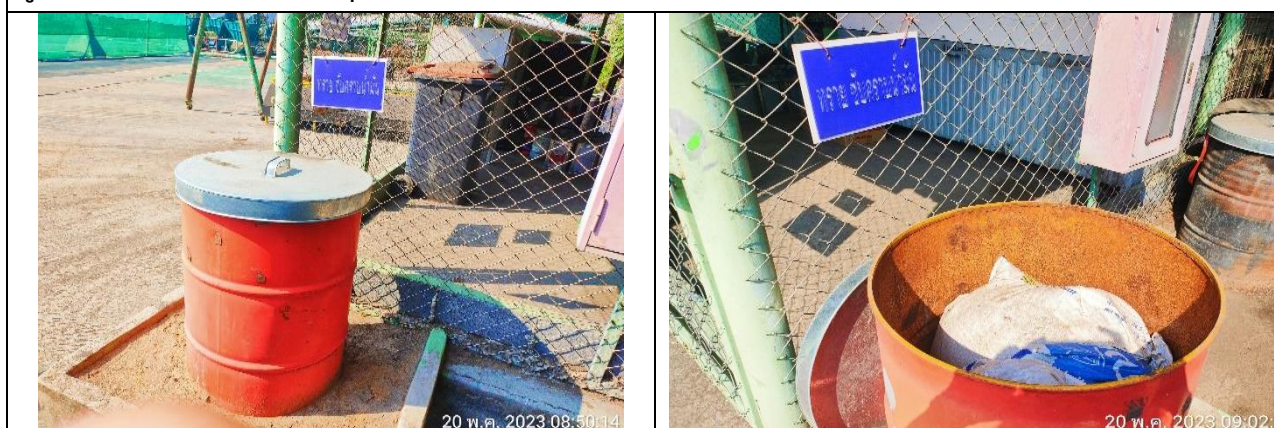
รูปที่ 2.2-33 ถังทรายดูดซับน้ำมัน
