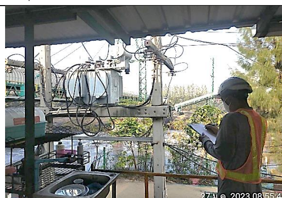
การตรวจสอบหม้อแปลงไฟฟ้า
